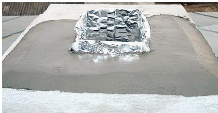
4.10 Поверх кровли на канал следует надеть металлический фартук, защищающий от попадания атмосферных осадков зазор между каналом и кровлей. Как альтернативный вариант можно использовать опцию – фиброцементную оболочку и клейкую термостойкую металлическую ленту для защиты устья канала на крыше.
