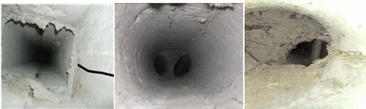
1. Некачественный монтаж во время строительства и монтажа блоков вентиляции (стыки негерметичны, разрушены внутренние стенки каналов, наложение одного блока на другой).
